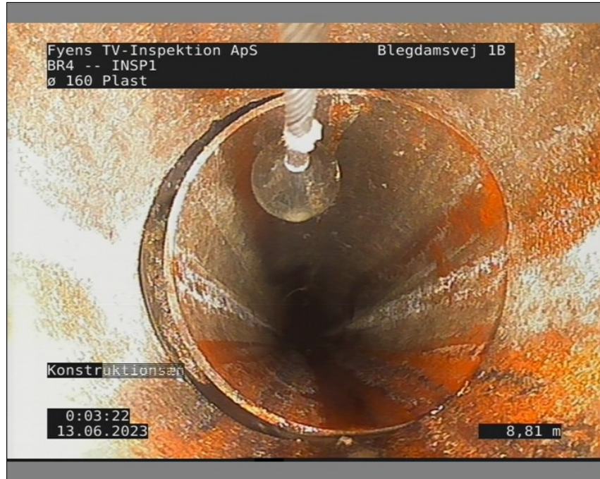
Foto: 16_9A, Medie #: 12062023, 00:03:22 8,8m, Konstruktionsændring klasse 2, Dimensionsændring, Materialeændring
