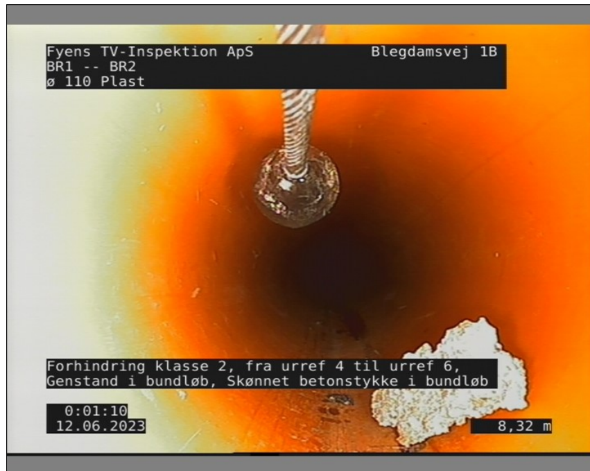
Foto: 3_7A, Medie #: 12062023, 00:01:11 8,3m, Forhindring klasse 2, fra urref 4 til urref 6, Genstand i bundløb
