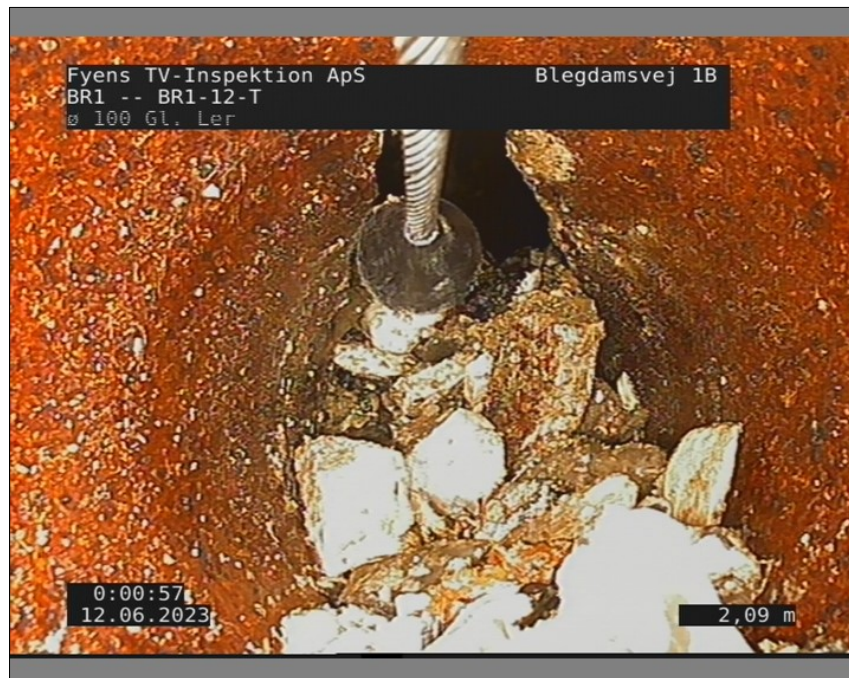
Foto: 1_5A, Medie #: 12062023, 00:00:58 2,1m, Aflejring klasse 4, fra urref 0 til urref 12, Sand/Grus
