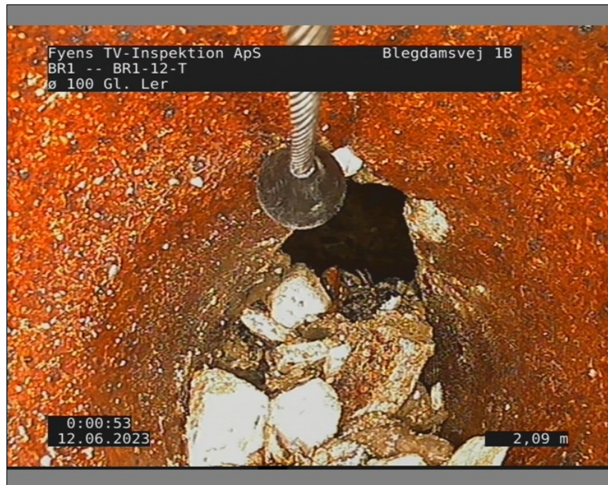
Foto: 1_4A, Medie #: 12062023, 00:00:53 2,1m, Rørbrud klasse 3, fra urref 10 til urref 2
