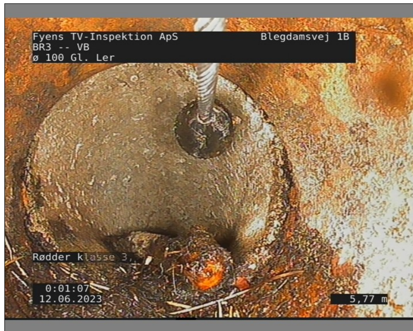
Foto: 5_10A, Medie #: 12062023, 00:01:08 5,8m, Rødder klasse 3, fra urref 4 til urref 8, Pælerod
